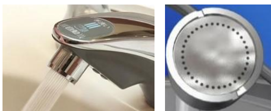
館内の水栓に節水コマを取付け
