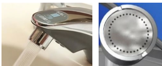
館内の水栓に節水コマを取付け
