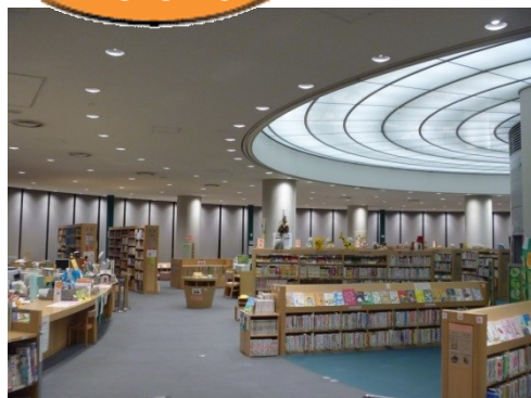
閲覧室内のダウンライト型LED照明化 (改修前の35%の消費電力)
