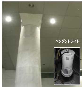
エントランス系統のLED照明化 (天井内にペンダントライトを設置)
