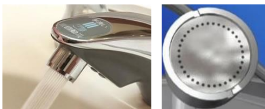
館内の水栓に節水コマを取付け
